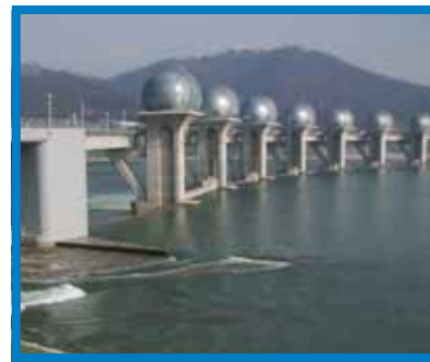
CH Yipo / Corea del Sur 3 x Kaplan PIT / 3330 kW
