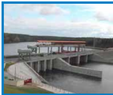
CH Grodnenskaya / Bielorrusia 5 x Kaplan PIT / 18, 870 kW
